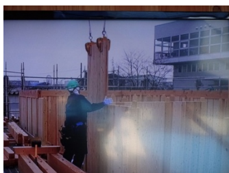
CLT パネルを柱の間に落とし込んでいる上棟時。
