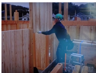
CLT パネルを柱の間に落とし込んでいる上棟時。
