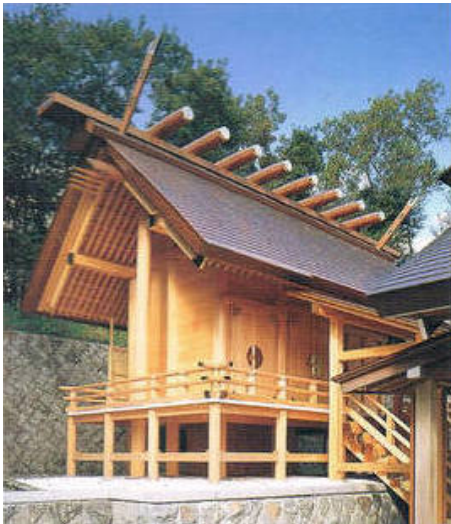
伝統的な板倉構法で造られた社殿 (菊池建設(株)パンフレットより)
